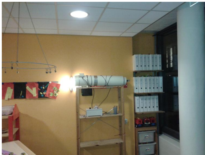
Figuur 5 Foto van de losstaande luchtreiniger (de witte “buis” bovenop de stellingkast) zoals geplaatst in de schapen speelkamer.
